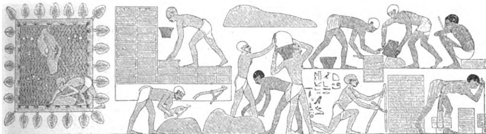
102. Maurer beim Bau einer Mauer des Amontempels. Theben. Grab des Rechrine. (Lepsius)
